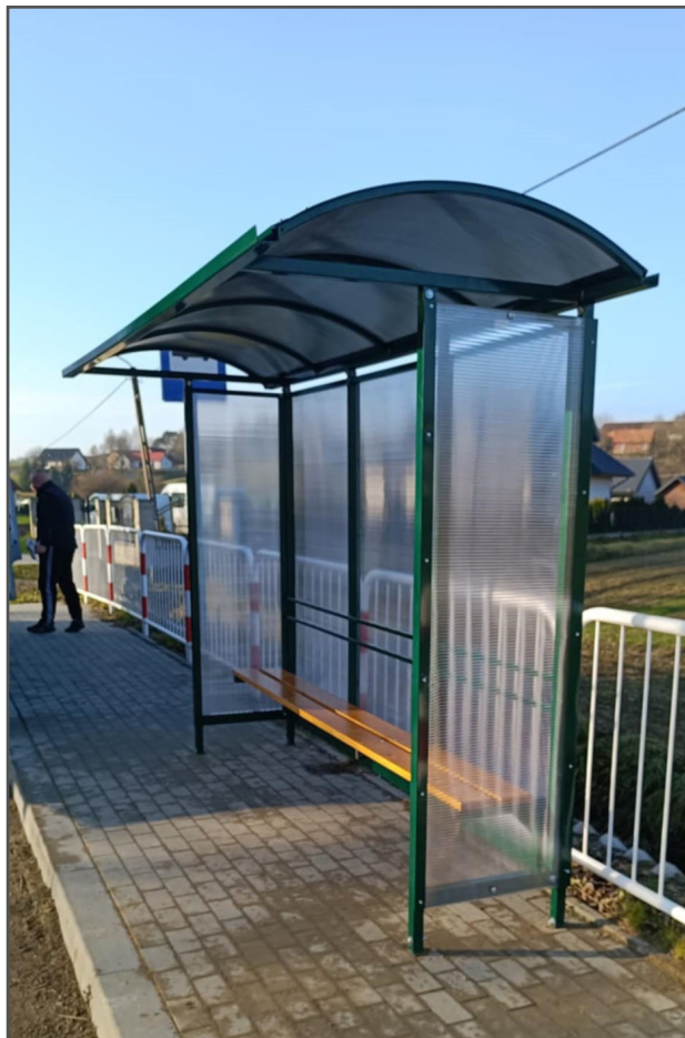
Wiaty przystankowa w miejscowości Wólka Batorska
