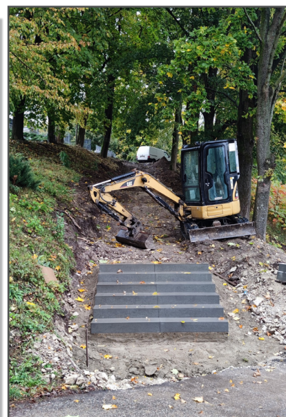
Modernizacja schodów przy cmentarzu parafialnym
