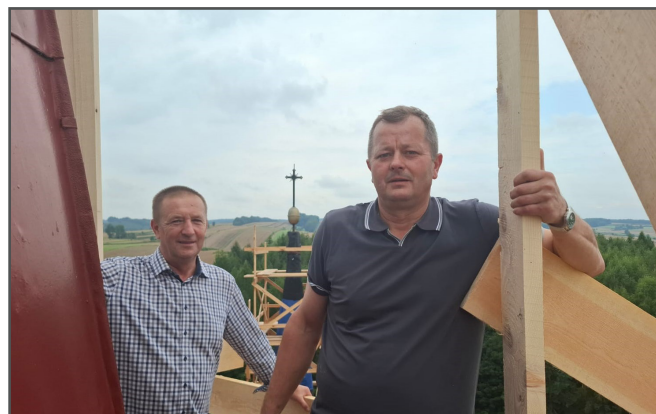
Wizyta nadzorująca przebieg inwestycji
