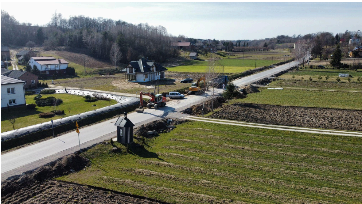
Rys. 12. Przebudowa drogi powiatowej w miejscowości Stawce.
