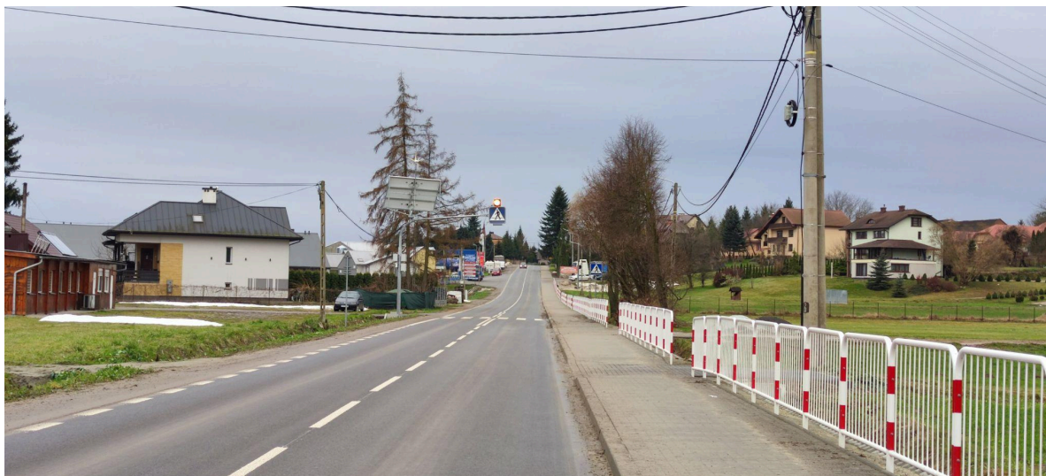
Rys. 13. Ukończona nawierzchnia drogi powiatowej na odcinku Batorz Pierwszy- Batorz Drugi.
