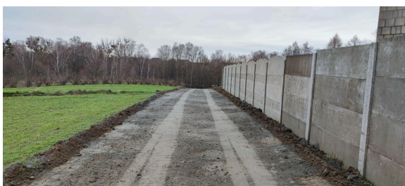
Rys.16. Odcinek drogi wewnętrznej w Błażku "za szkołą".
