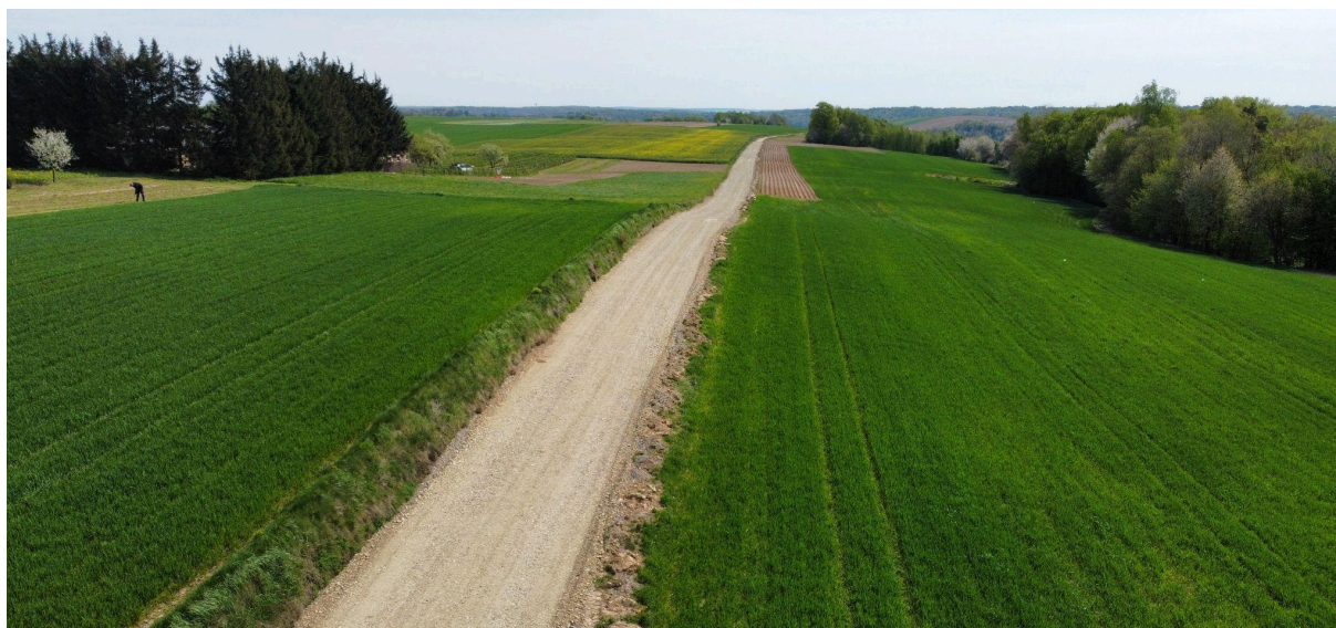
Rys. 10. Odcinek drogi wewnętrznej Wólka Batorska – Kolonia – Stawce podczas prac przygotowawczych.
