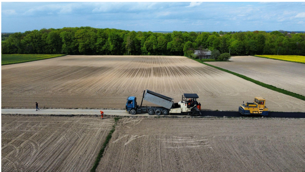
Rys. 11. Odcinek drogi Wola Studzieńska - "Batórka" podczas układania warstwy asfaltowej.
