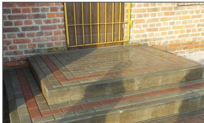
Schody przed budynkiem remizy OSP w Stawcach-Kolonii
