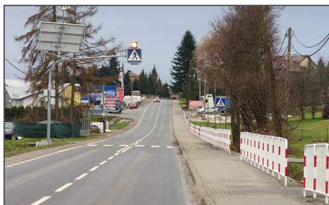
Odcinek drogi powiatowej naprzeciwko stoku
