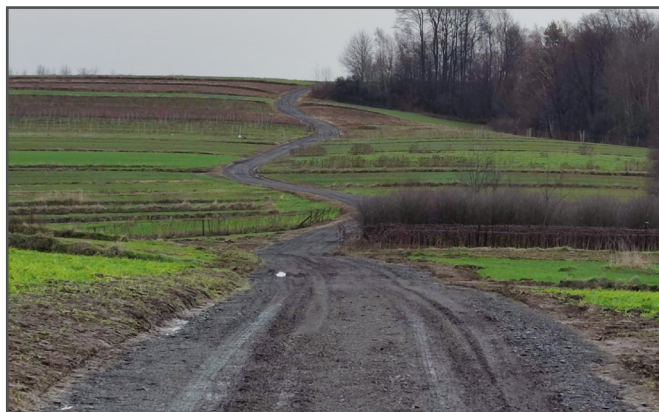
"Zamkowa droga" z nową nawierzchnią
