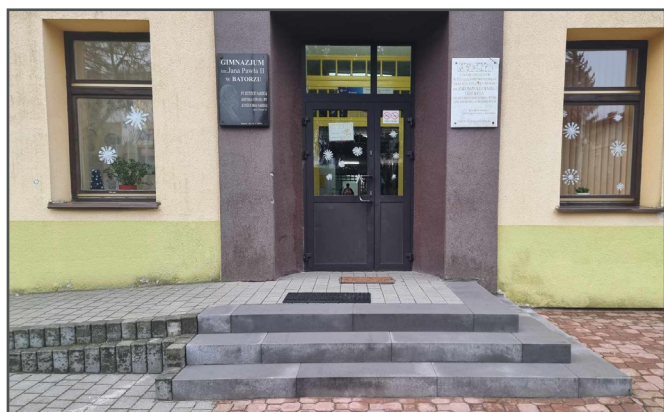
Schody przy budynku szkoły ZSP w Batorzu
