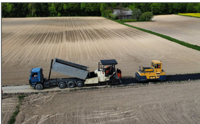
Przebudowa drogi wewnętrznej Wola Studzieńska - "Batórka"
