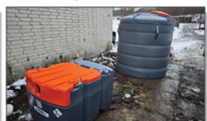
ZBIORNIKI NA PALIWO
