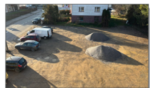
NOWY PARKING W BEZPOŚREDNIM SĄSIEDZTWIE BUDYNKU URZĘDU GMINY
