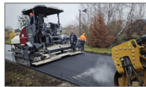
PRACE BUDOWLANE NA ODCINKU DRÓGI GMINNEJ W MIEJSCOWOŚCI BŁĄZEK
