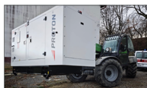
ODBIÓR AGREGATU PRĄDOWIRZĄCEGO
