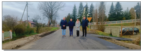
W DNIU 04 GRUDNIA 2025 R. DO KONA ODBIORU ODCINKA DRÓGI W MIEJSCOWOŚCI BŁĄZEK
