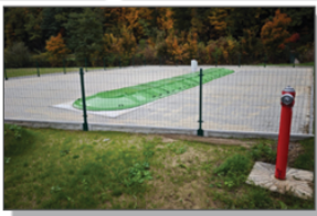
PRACE BUDOWLANE W RAMACH PROJEKTU "POPRAWA GOSPODARSTWA WODNO - ŚCIEKOWEJ W GMINIE BATORZ"
