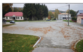
PARKING PRZY KOŚCIELE PARAFIALNYM W BATORZU
