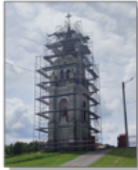
Rozpoczęcie prac związanych z wymianą dachu na dzwonnicy
