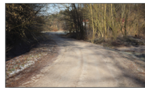
Droga w Węglniku wymagająca modernizacji
