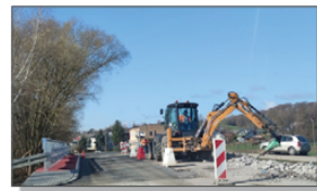
Modernizacja mostu na drodze powiatowej w miejscowości Wólka Batorska
