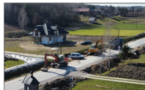
Prace budowlane na drodze powiatowej nr 2304L w miejscowości Stawce
