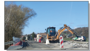
Modernizacja mostu na drodze powiatowej w miejscowości Wólka Batorska
