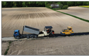
Przebudowa drogi w wewnętrznej Wola Studzińska - "Batórka"
