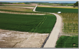
Prace przygotowawcze pod przebudowę drogi wewnętrznej Wola Studzińska - "Batórka"
