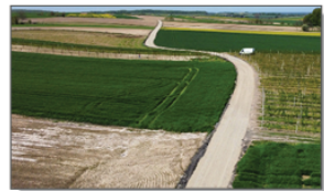
Prace przygotowawcze pod przebudowę drogi wewnętrznej Wola Studzińska - "Batórka"
