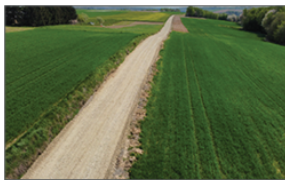
Prace przygotowawcze przebudowy drogi gminnej Wólka Batorska - Kolonia - Stawce
